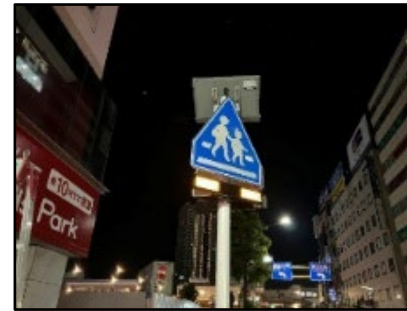
RRFBのビーコン（船橋市）
